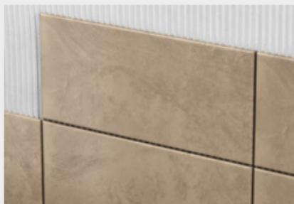
Figure 24 : Carrelage directement collé sur plaques fermacell®.
