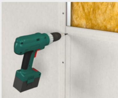
Figure 7 : Vissage sur ossature métallique
