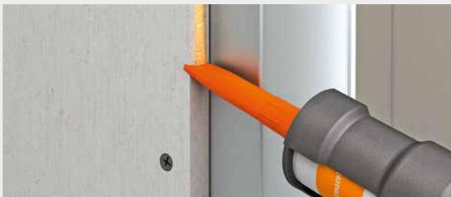
Faire glisser la cartouche de 310 ml le long du chant de la plaque. L'embout spécial de la cartouche permet d'appliquer la quantité exacte de colle sur la largeur du chant de la plaque de 10 ou 12,5 mm. Pour les plaques d'épaisseur 15 ou 18 mm, on coupera l'embout.
