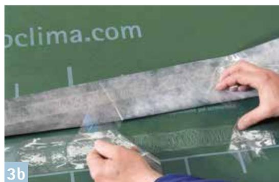
en évitant d'exercer une traction, d'appliquer une charge et de former des plis. Dans le cas d'INTESANA connect, coller le chevauchement des bandes à l'aide des deux zones autocollantes intégrées. Bien frotter les endroits collés pour qu'ils adhèrent au support (PRESSFIX).
